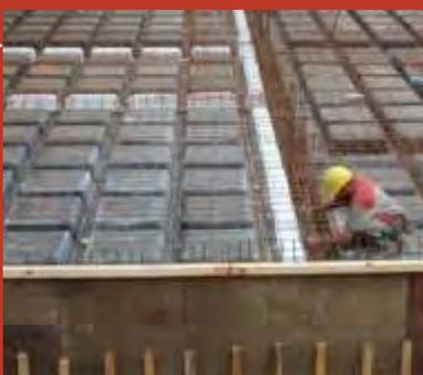
Assoalho em cubetas de polipropileno pronto para armação das lajes.
