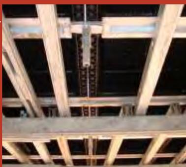
A laje concretada, com a cabeça de reescoramento pronta para a colocação das escoras metálicas.
