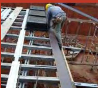
Colocação do compensado nos trechos maciços e início do posicionamento das régulas para apoio das cubetas.
