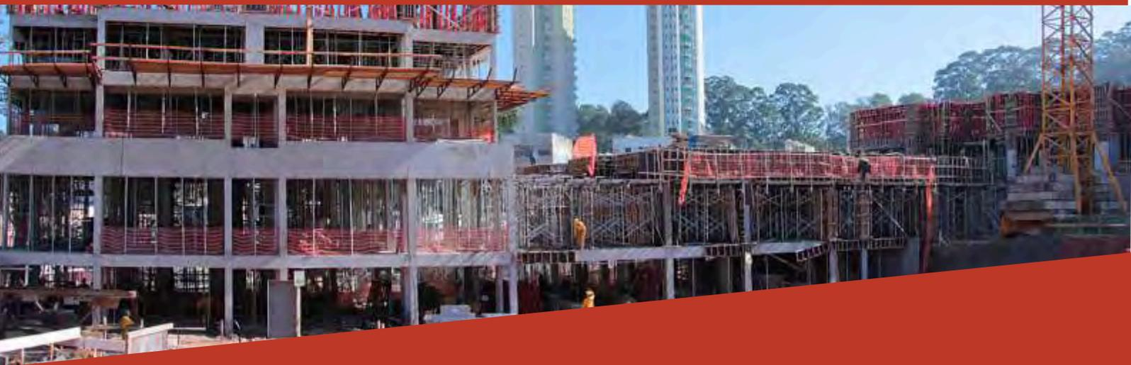
O escoramento metálico JIRAU é um sistema para execução de vigas e lajes convencionais ou nervuradas (cubetas). É um sistema leve, prático e versátil que gera aumento de produtividade com segurança. Proporciona economia no custo com madeiramento e rapidez na montagem, refletindo na redução de prazo e orçamento da obra. É composto por três equipamentos básicos: quadros tubulares, vigas metálicas e acessórios.
