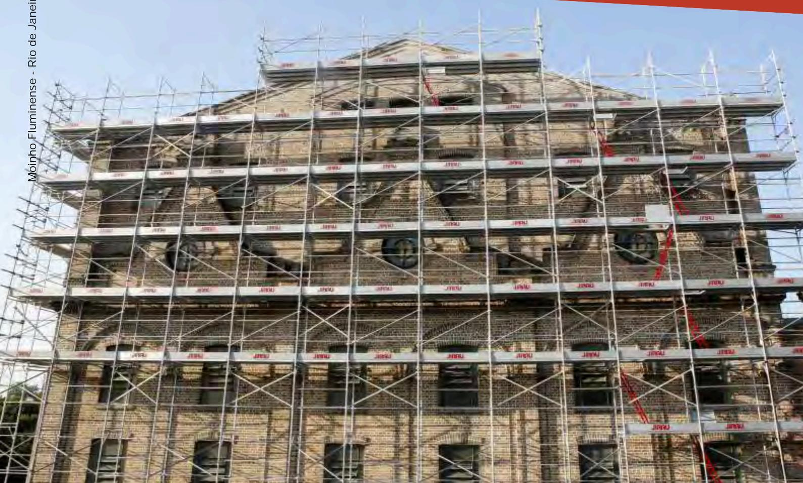
Andaime tubular composto de piso metálico antiderrapante, rodapé metálico (h=20cm) e guarda-corpo posicionado a 0,70m e 1,20m de acordo com altura especificada na norma (NR18).
