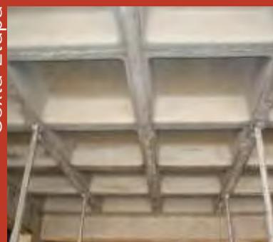
Reescoramento das lajes nervuradas após a retirada das cubetas do escoramento e das régulas metálicas, ficando apenas as escoras e as cabeças de reescoramento.
